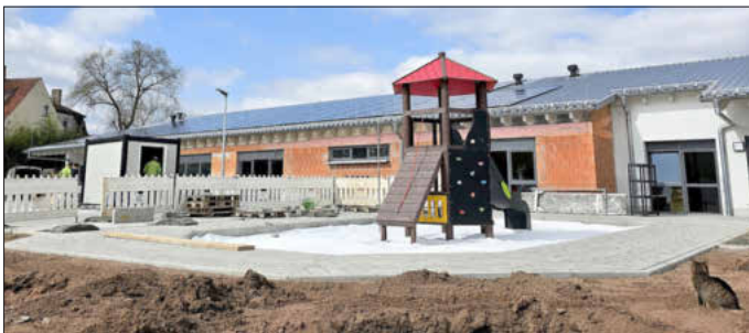
Noch laufen am Gemeindezentrum einige Arbeiten, die Kita im rechten Gebäudeteil ist aber bereits bezogen.
